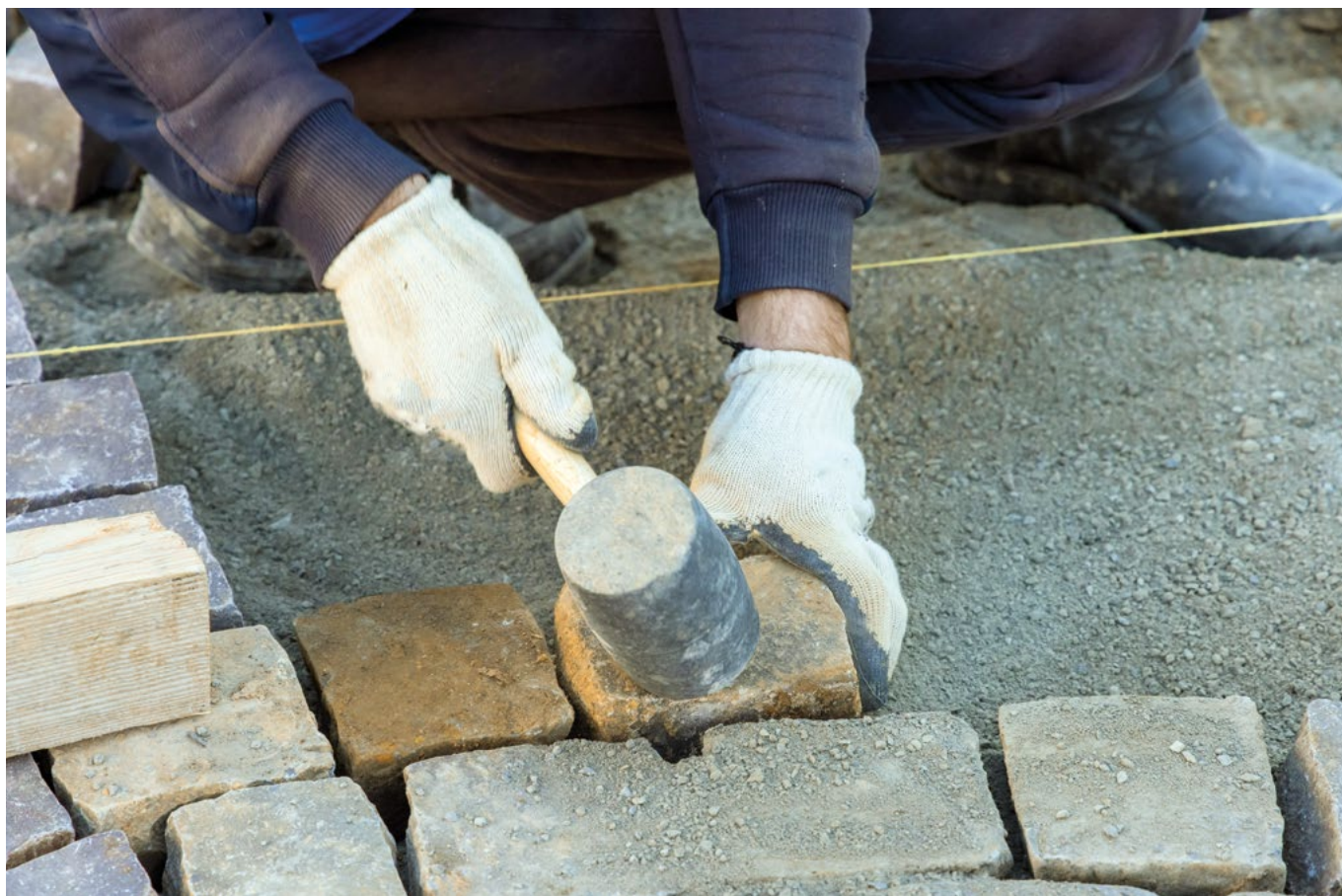
Operazioni di posa del porfido
