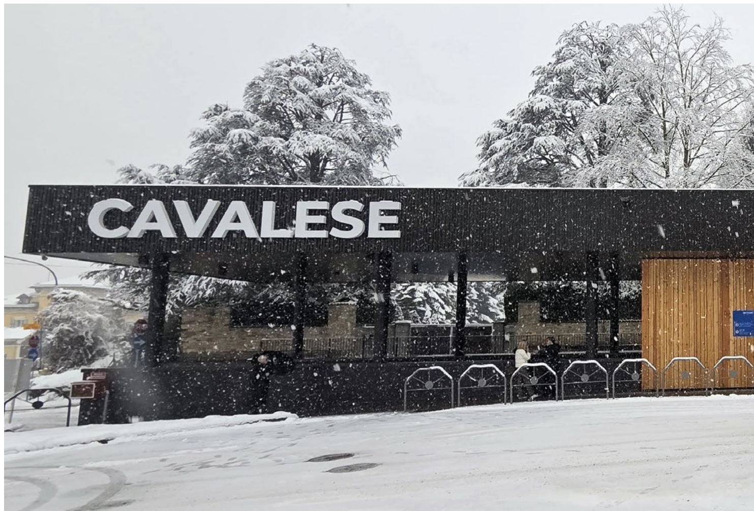
Il Centro intermodale di Cavalese
