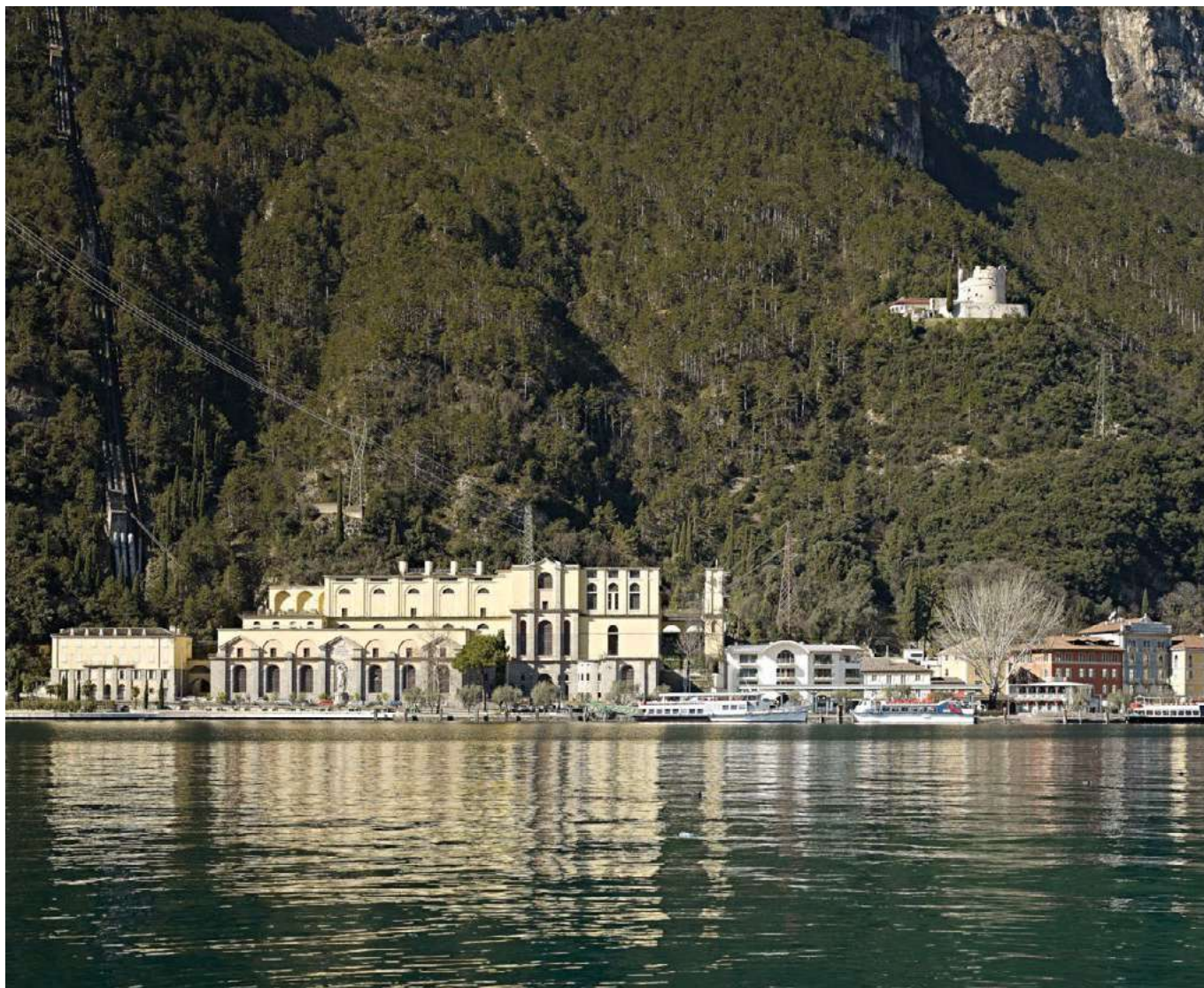
La centrale idroelettrica di Riva del Garda
