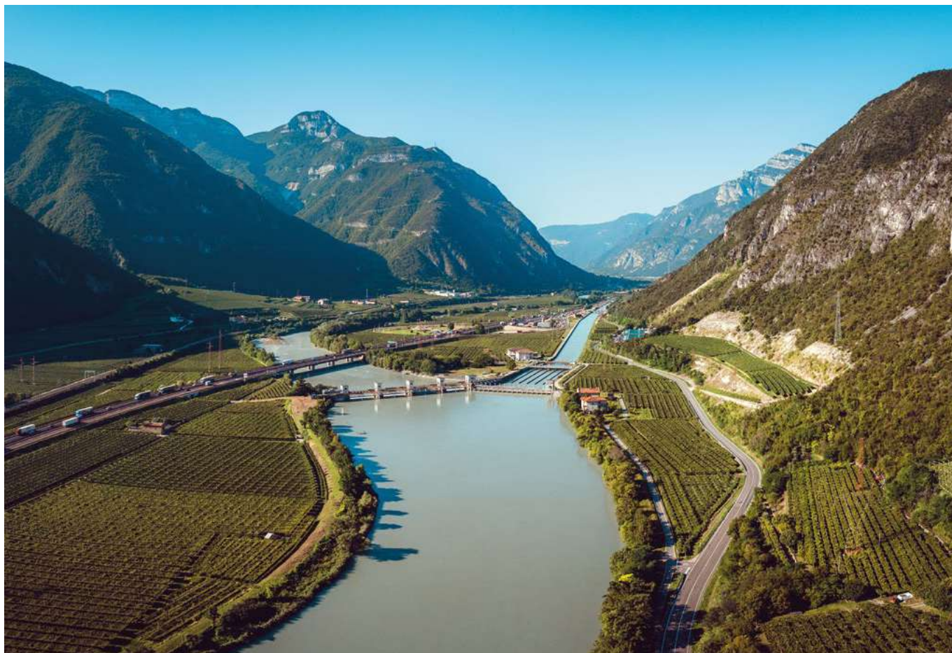
Sulla destra il canale Biffis, opera di presa sul fiume Adige
