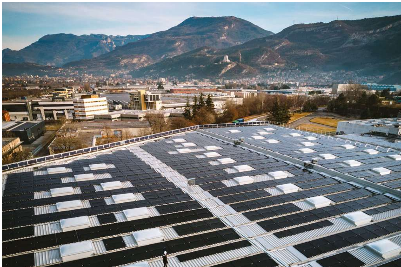
Impianto fotovoltaico a Rovereto
